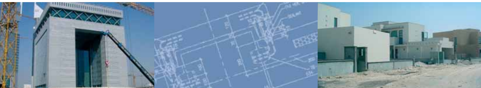
Portalbygningen til Dubai International Financial Centre, hvor fabrikken i Dubai har leveret 16.000 m 2 huldæk.
