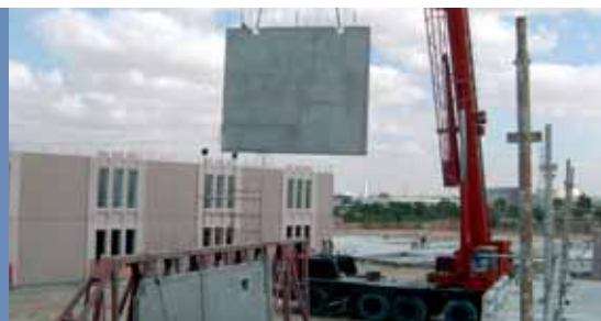
Endnu et element af de i alt 4.500 m 2 vægelementer løftes på plads på American School i Abu Dhabi.
