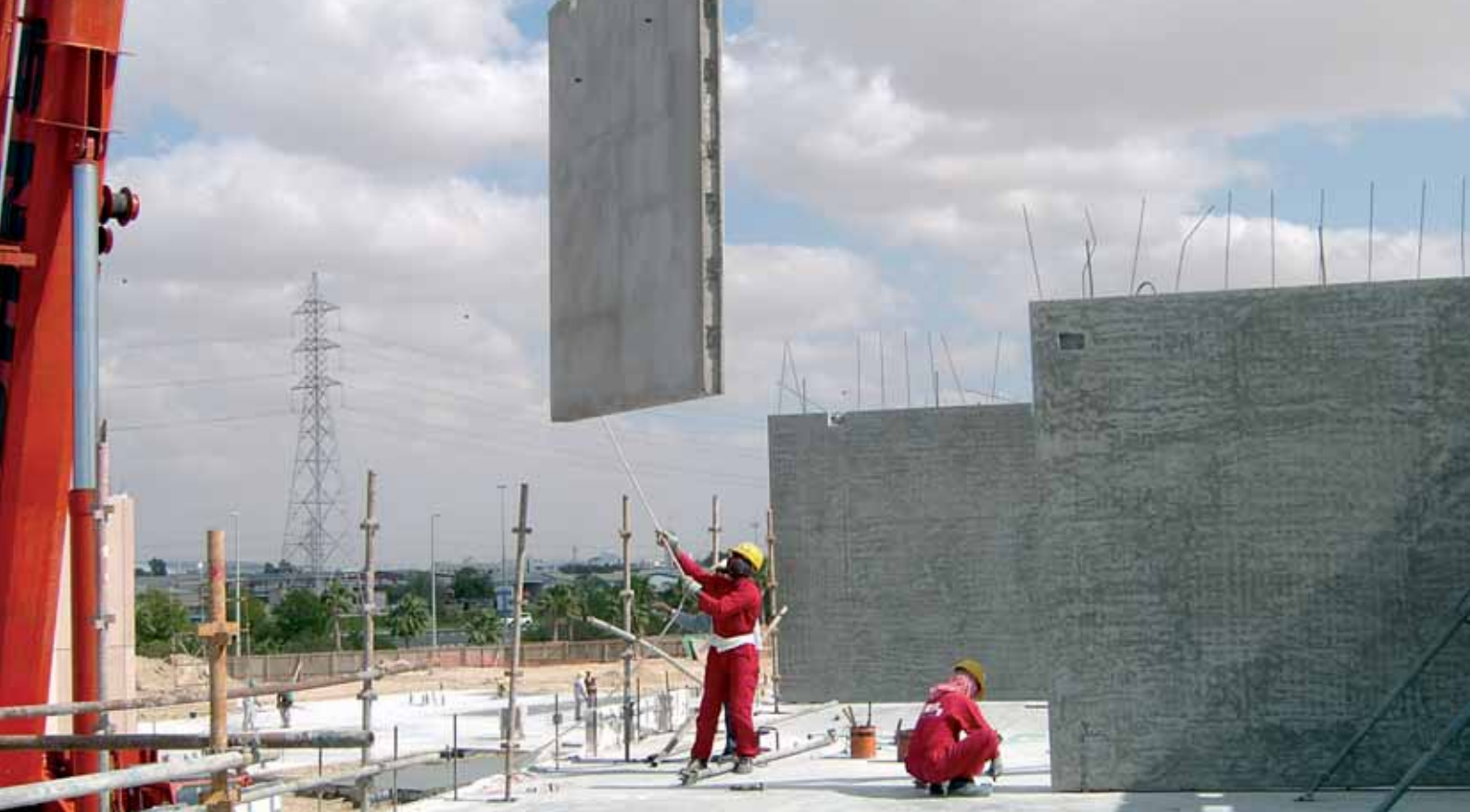
Fabrikken i Abu Dhabi har leveret søjler, bjælker, trapper og interne vægge til American School. Her monteres vægelementerne.
