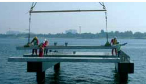
Montageholdet er flyttet på vandet for at montere kraftige søjler, bjælker og huldæk på en understøtning.
