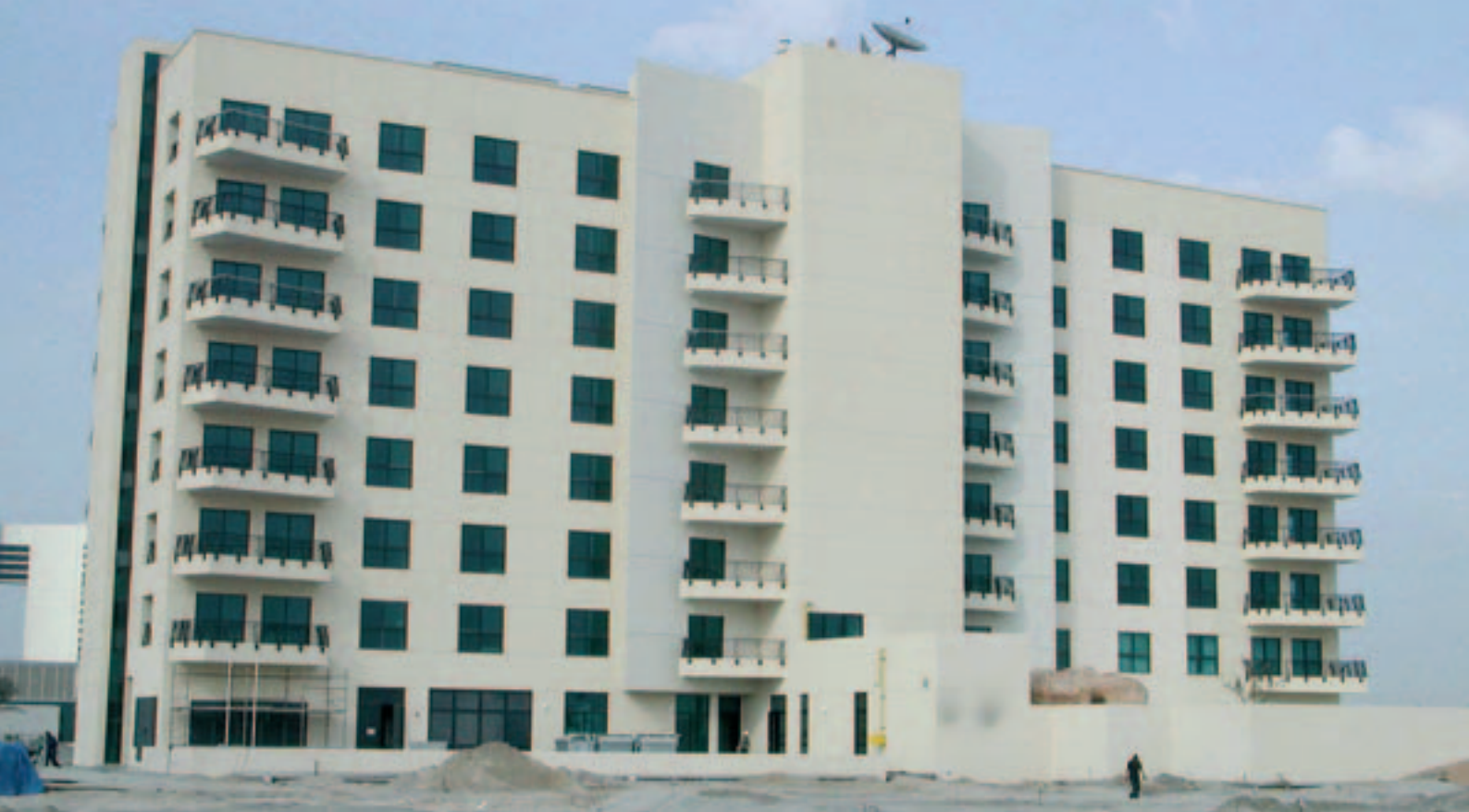
Sheikh Manna Bin Khalaf Al Maktoum Building i Dubai er en beboelsesejendom, hvortil der er leveret ca. 22.000 m 2 huldæk.
