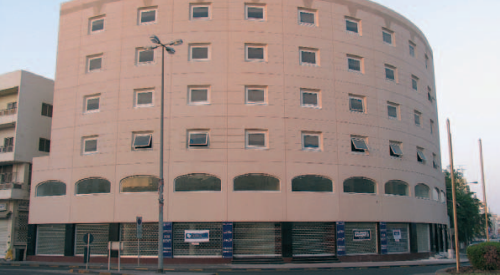
Den runde form på denne erhvervsjendom i Bahrain er skabt af 56 avancerede facadeelementer, som følger bygningens kurve.
